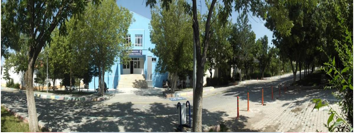
Resim 1. Meslek Yüksekokulu Hizmet Binası
